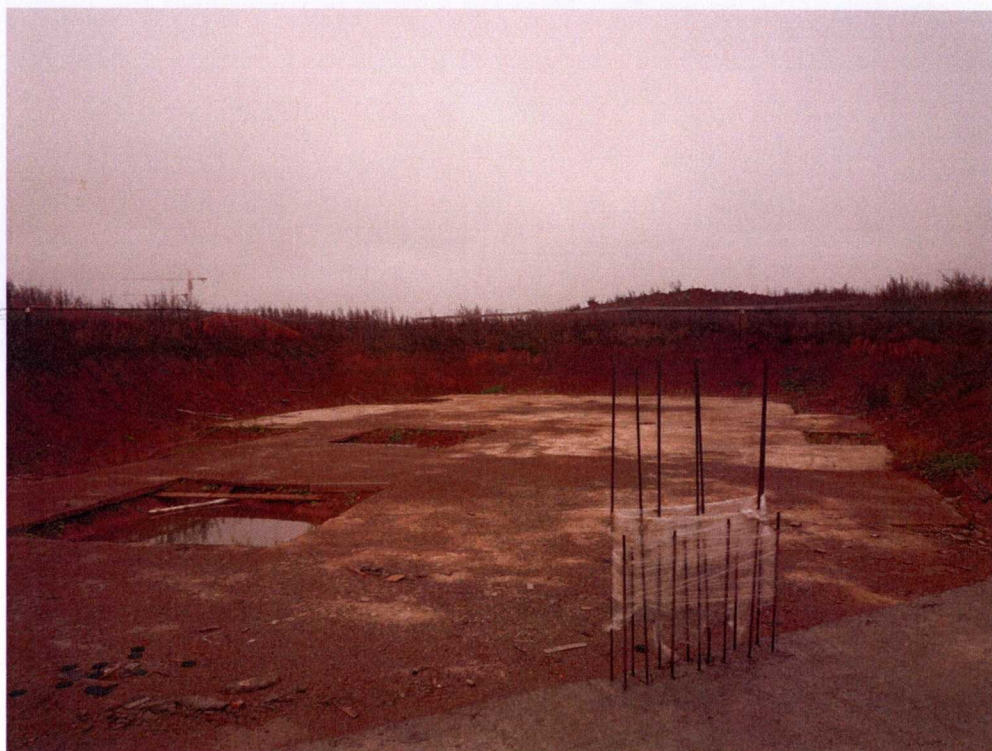
Фото № 2. Общий вид секции 1 со стороны секции 2
