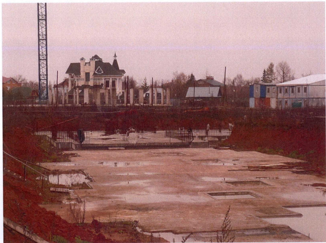
Фото № 13. Общий вид котлована в зоне сопряжения секций 3 и 4
