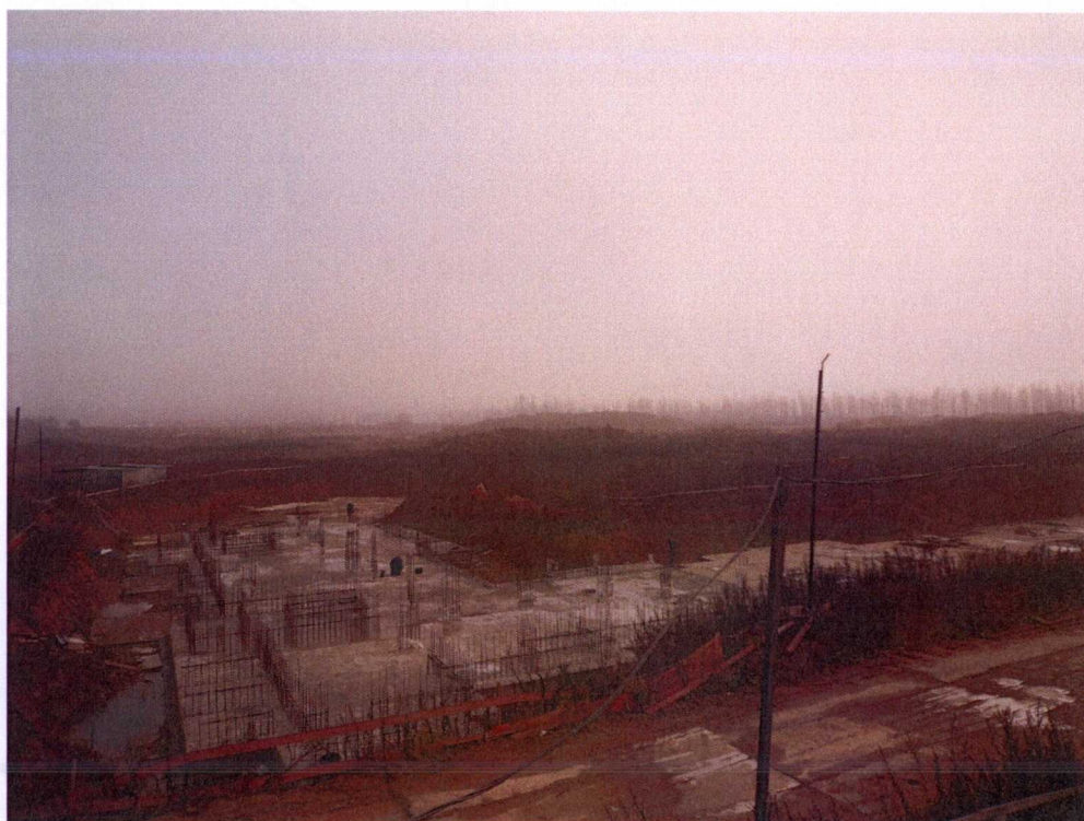
Фото № 1. Общий вид фундаментов здания
