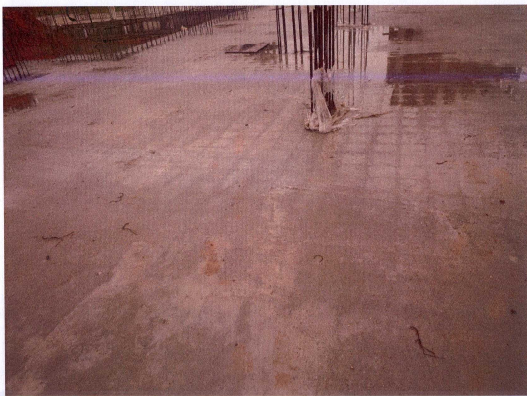
Фото № 7. Вид фундаментной плиты в зоне секции 2
