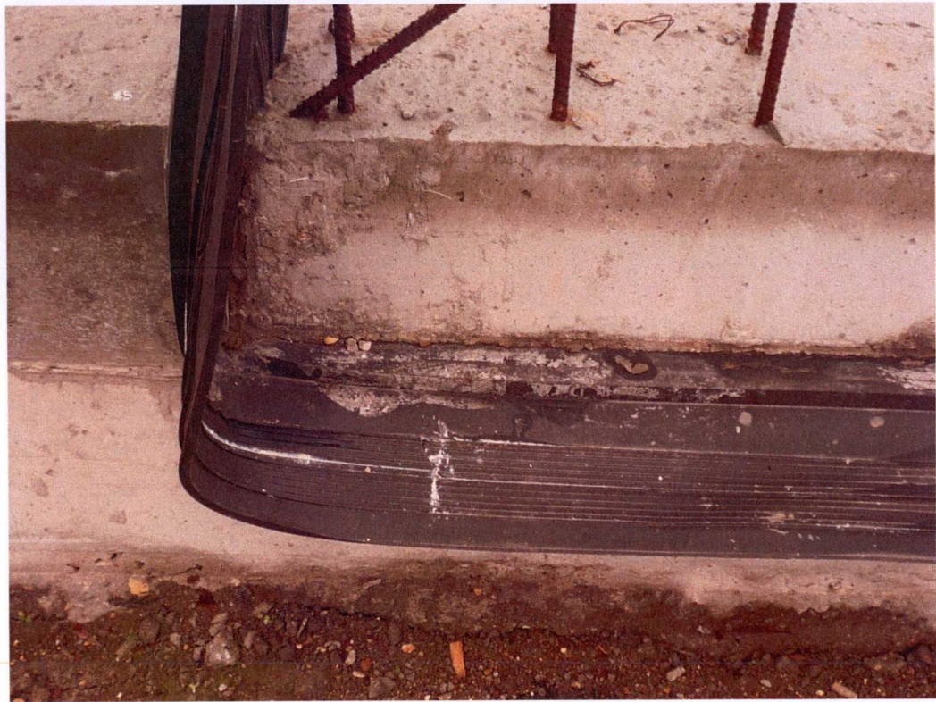
Фото № 10. Гидроизоляционная шпонка в зоне деформационного шва
